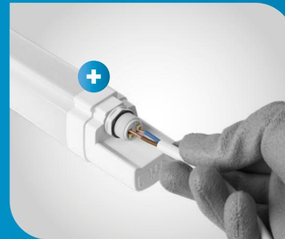
Kabel durch die Kabelverschraubung führen und Stromkabel L und N anschließen.
