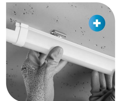
**2** Am eingebauten Montageelement "klicken" wir die elektrisch angeschlossene Lampe ein. Fertig!
